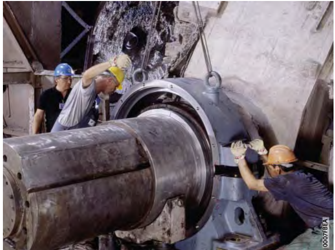
Figura 1 Servicios de montaje por parte de los expertos de Schaeffler
