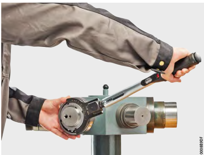
Figura 11 Montaje mediante llaves de doble gancho
