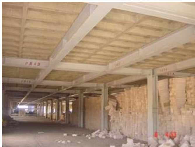
Figura 3.47 Losa apoyada en traves
