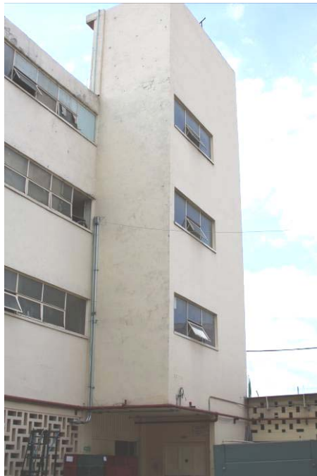
Figura 3.27 Marcos o muros que no llegan a la cimentación
