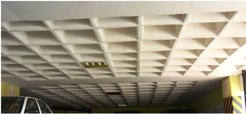
Figura 3.53 Losa aligerada (reticular)
