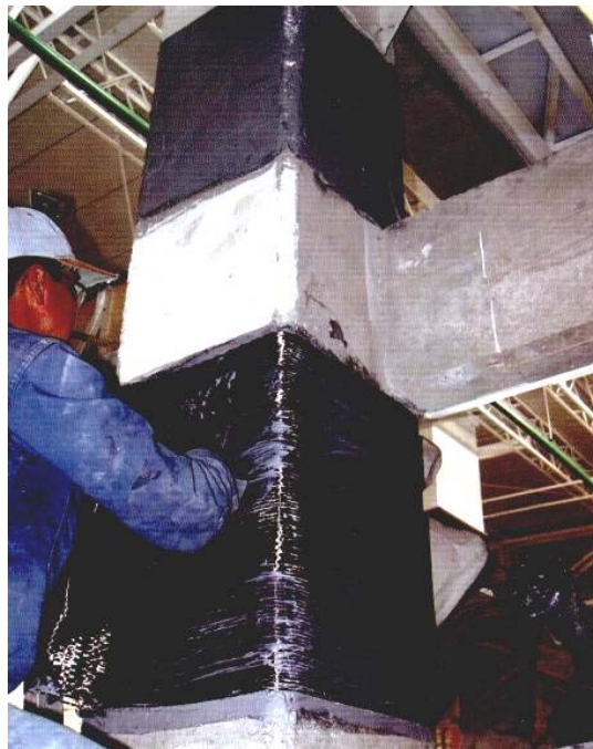
Figura 3.65 Rehabilitación con fibras de carbono
