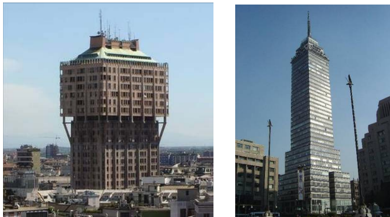
Figura 3.29 Cambio abrupto de la planta en niveles superiores
