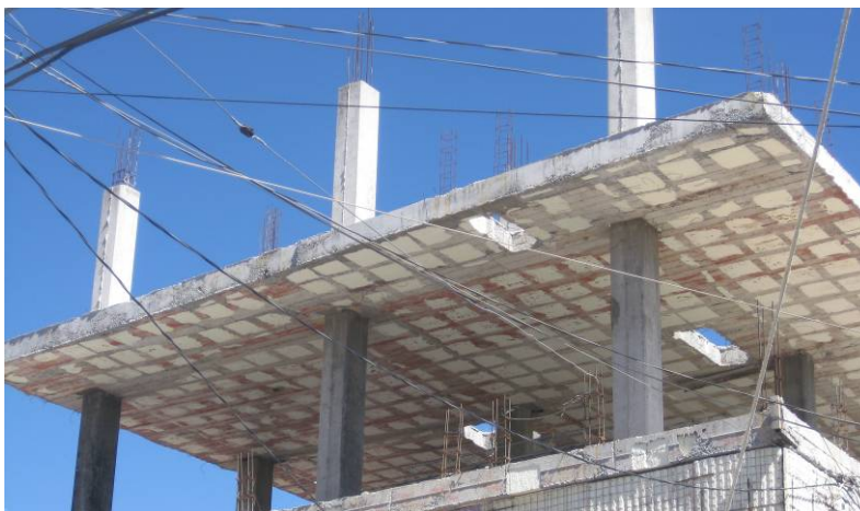
Figura 3.48 Losa plana. Nótese las nervaduras principales y la falta de “capitel”
