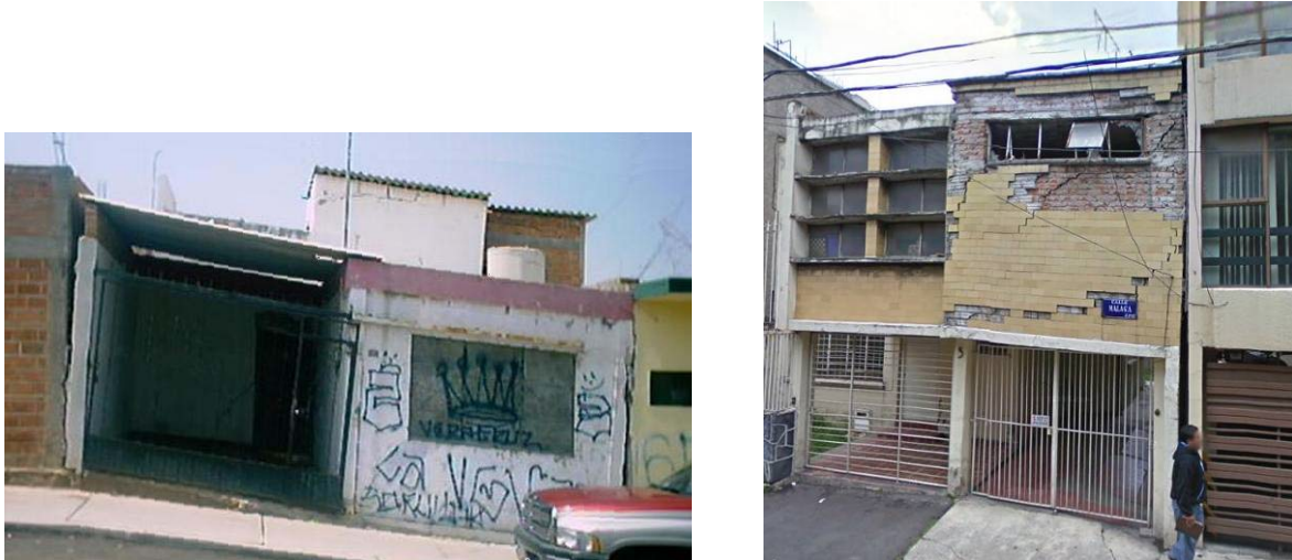
Figura 3.68 Hundimientos diferenciales
