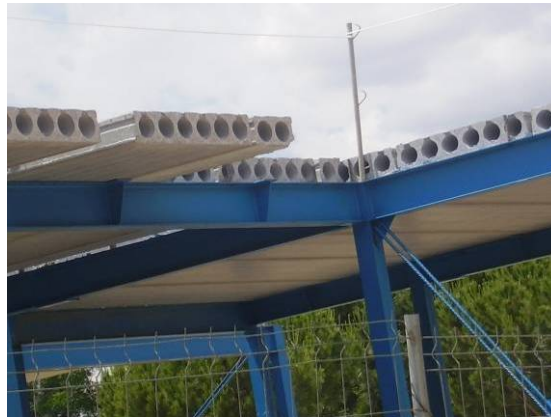
Figura 3.55 Losas alveolares (Soria y navaleno, 2011)
