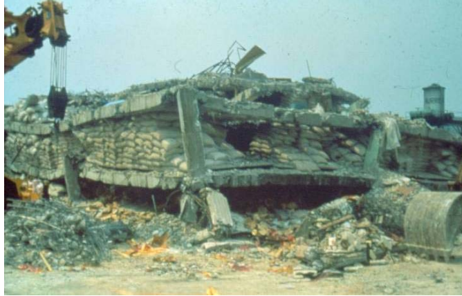
Figura 3.32 Grandes masas en pisos superiores
