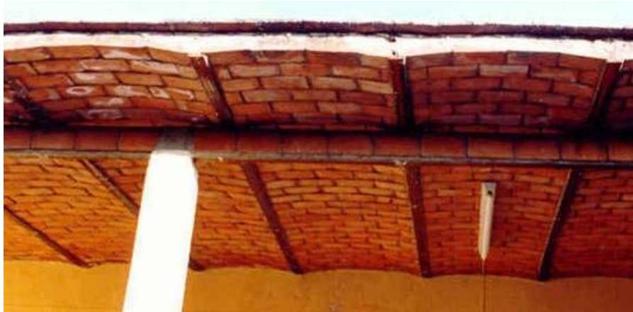
Figura 3.50 Bóveda catalana (vigas y enladrillado)
