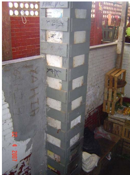
Figura 3.62 Encamisado de acero
