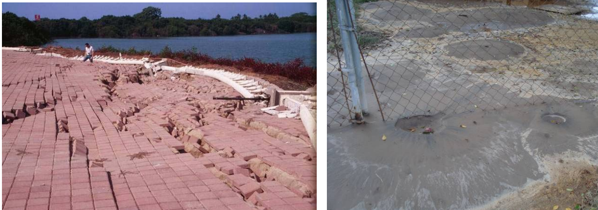
Figura 3.71 Efecto de la licuación de arenas
