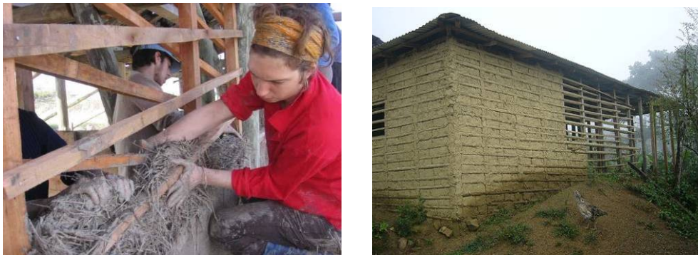
Figura 3.37 Fabricación de bahareque
