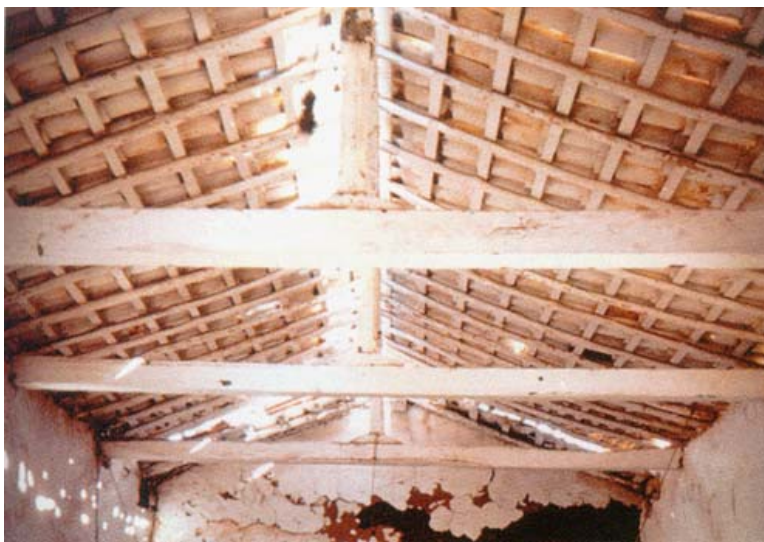
Figura 3.51 Vigas, largueros y cubierta
