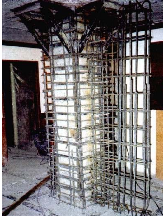
Figura 3.61 Encamisado de concreto
