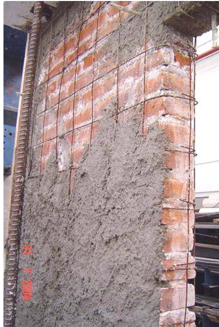
Figura 3.63 Refuerzo en muro con malla y mortero
