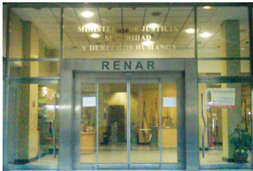
HALL DE ACCESO AL NUEVO EDIFICIO DE LA SEDE CENTRAL DEL RENAR SITA EN BME. MITRE 1469 CAPITAL, ADQUIRIDA CON FONDOS PROPIOS DERIVADOS DE LA APLICACION DE LA LEY 23.979.
