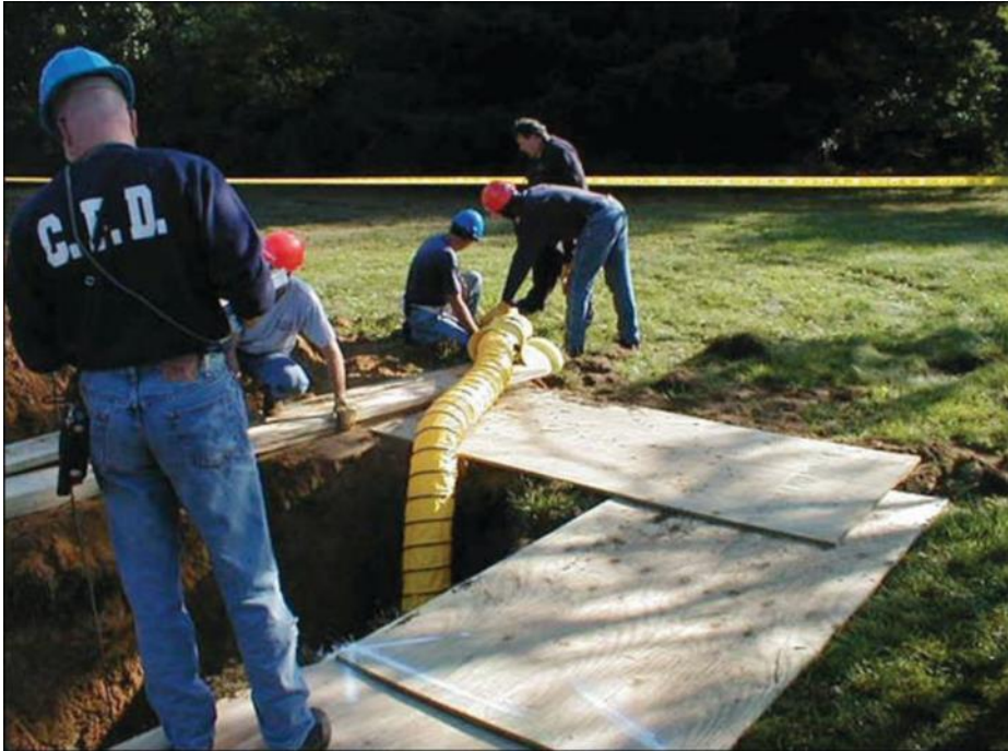
Figura 30. Colocación de paneles y ventilación.
