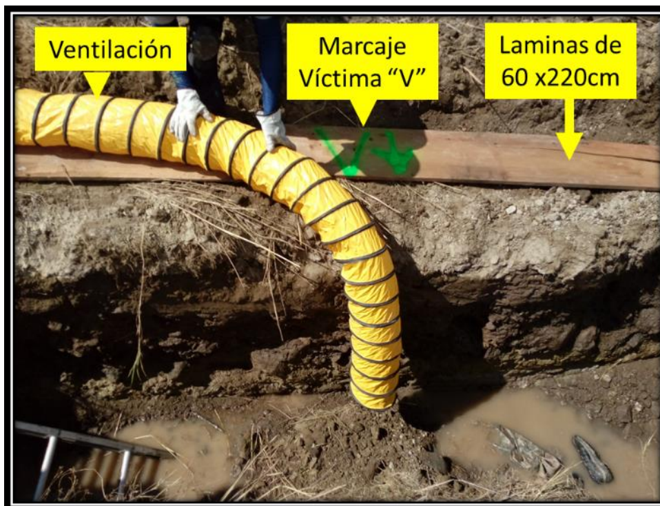
Figura 25. Colocación de equipos antes de entrar a la zanja.
