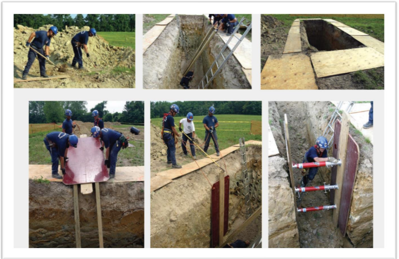
Figura 33. Secuencia de algunos pasos en rescate en zanja tradicional o recta.
