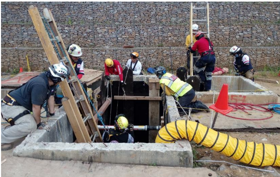
Figura 24. Trabajo en Zanjas, curso rescate en zanjas Academia Regional Centroamericana de Búsqueda y Rescate.
