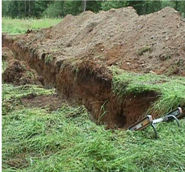
Figura 7. Vista inicial de la Zanja.
