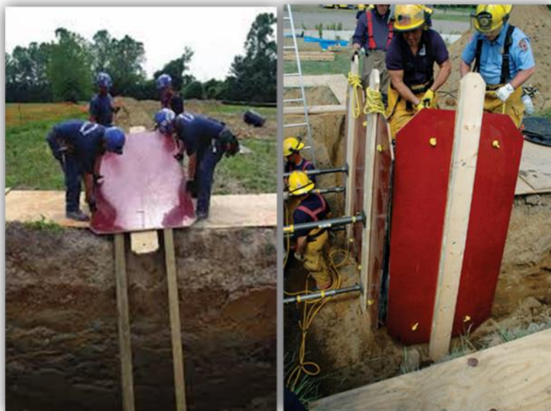
Figura 31. Colocación de paneles o gran pads.
