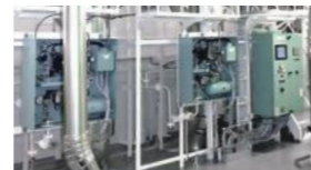
本船設置状況
