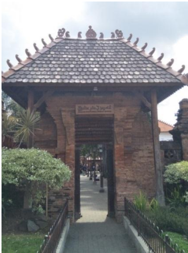
Gambar 4.9 Gapura Paduraksa Masjid Menara Kudus (Foto: dokumen penulis)
