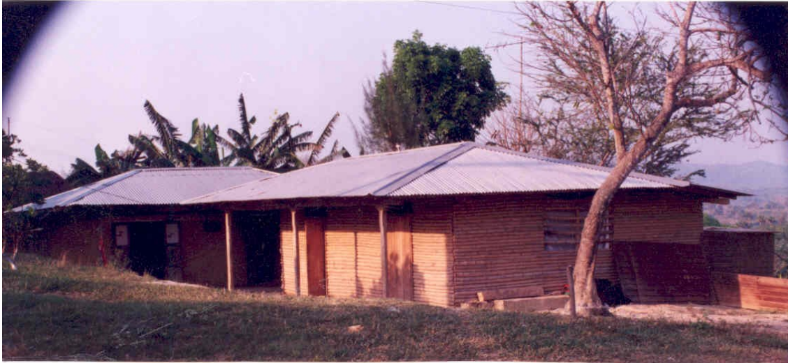
Figura 2. Una característica de la vivienda tradicional donde se evidencia la sustitución en la cubierta de la palma, zacate o teja por lámina metálica.
