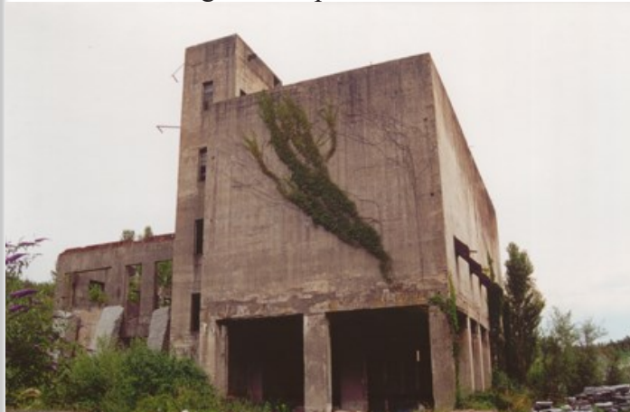
Antigua trituradora de piedras del campo de Gusen
