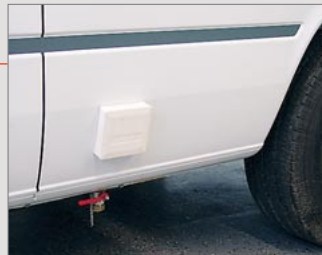
Kaminklappe der Gasheizung
