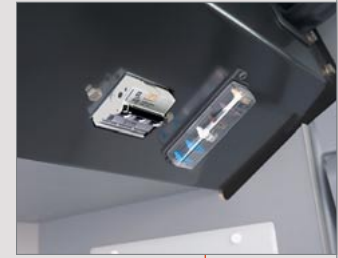
Fehlerstromschutzschalter und Sicherungen
