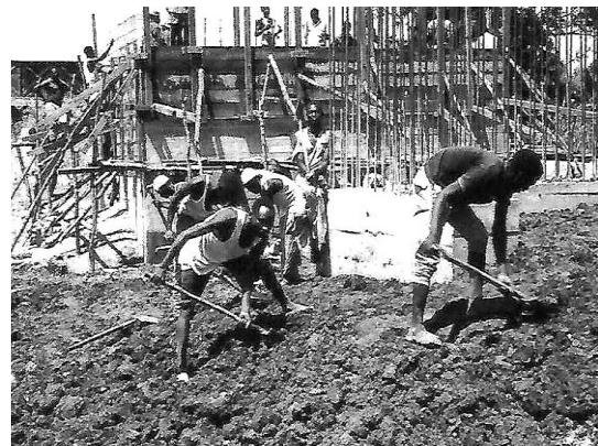
Construction de la structure d'un pont
