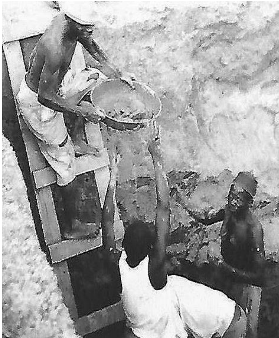
Excavation des fondations d'un pont
