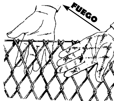
Fig. 30: Manchas de hollín sobre una valla
