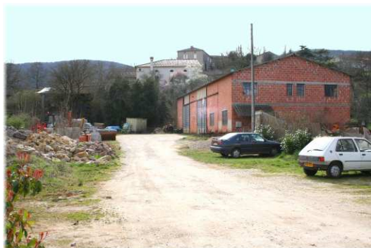
Entreprise de maçonnerie
