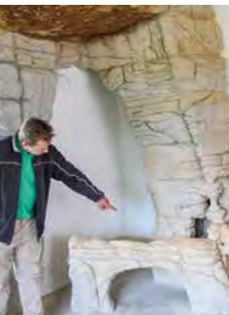
Jan Lorenz erklärt Elemente des Sandsteinzimmers: „Hier wird einmal der Kamin stehen“
