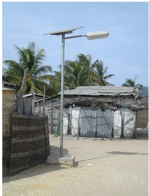
Lampadaire solaire à Elinkine, un village de Casamance (Sénégal).
