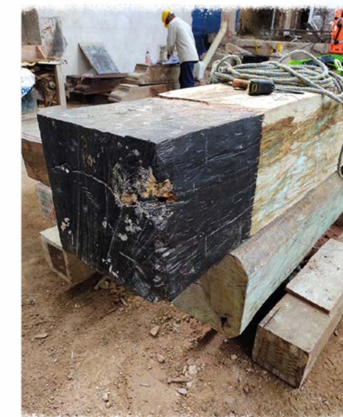
Columnas en madera.
