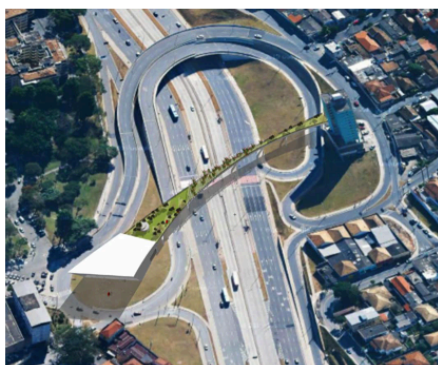
Passarela Boulevard Arq. Joel Campolina
