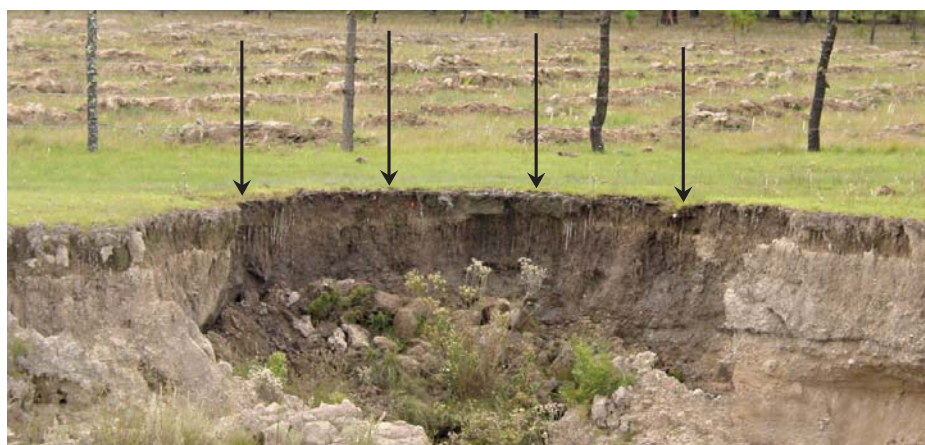
FIGURA 118. ÁREA DE LA CÁRCAVA QUE RECIBE LOS ESCURRIMIENTOS
