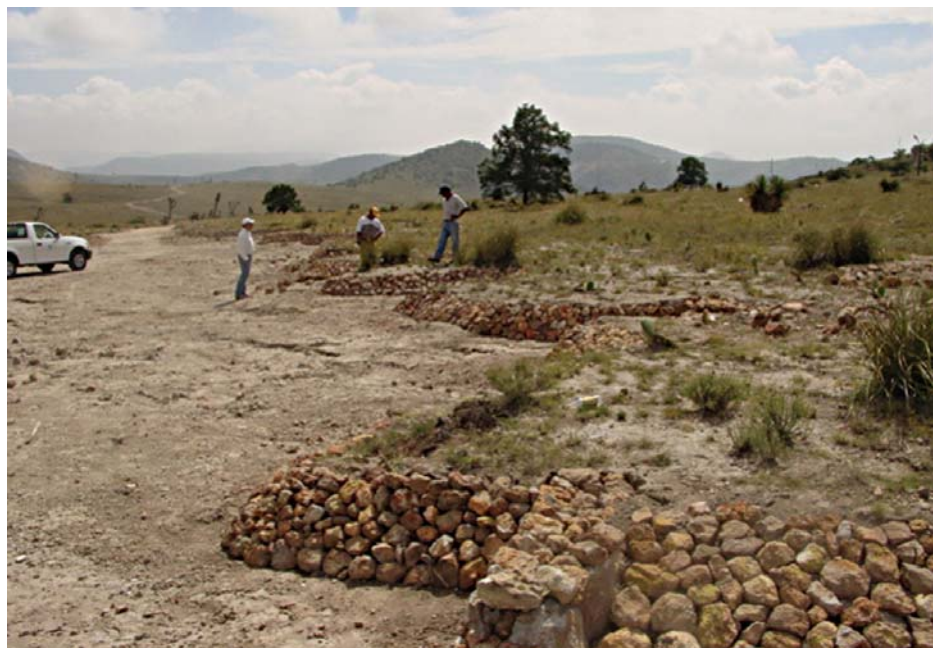
FIGURA 122. ESTABILIZACIÓN DE TALUDES
