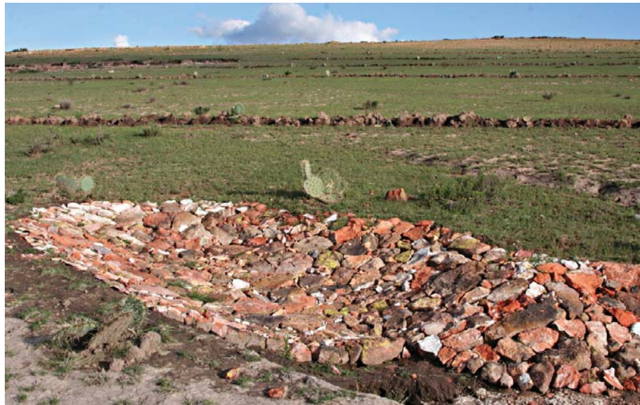
FIGURA 117. CABECEO DE CÁRCAVAS
