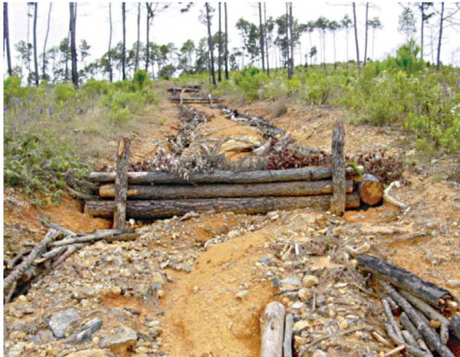
FIGURA 125. OBRAS DE PROTECCIÓN Y CONSERVACIÓN DE CAMINOS FORESTALES
