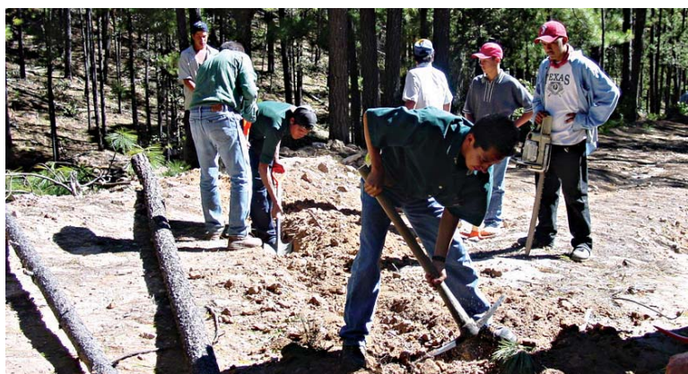
FIGURA 129. CONSTRUCCIÓN DE UN CANAL DE DESAGÜE
