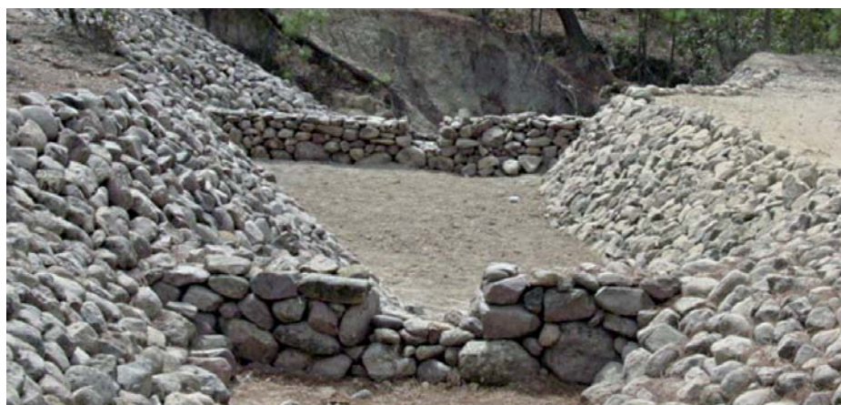
FIGURA 124. ESTABILIZACIÓN DE TALUD CON PIEDRA
