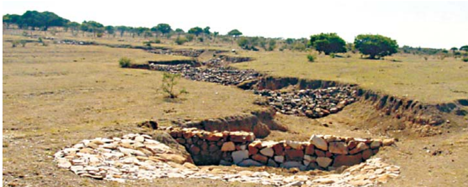
FIGURA 121. RECUBRIMIENTO DE UNA CÁRCAVA
