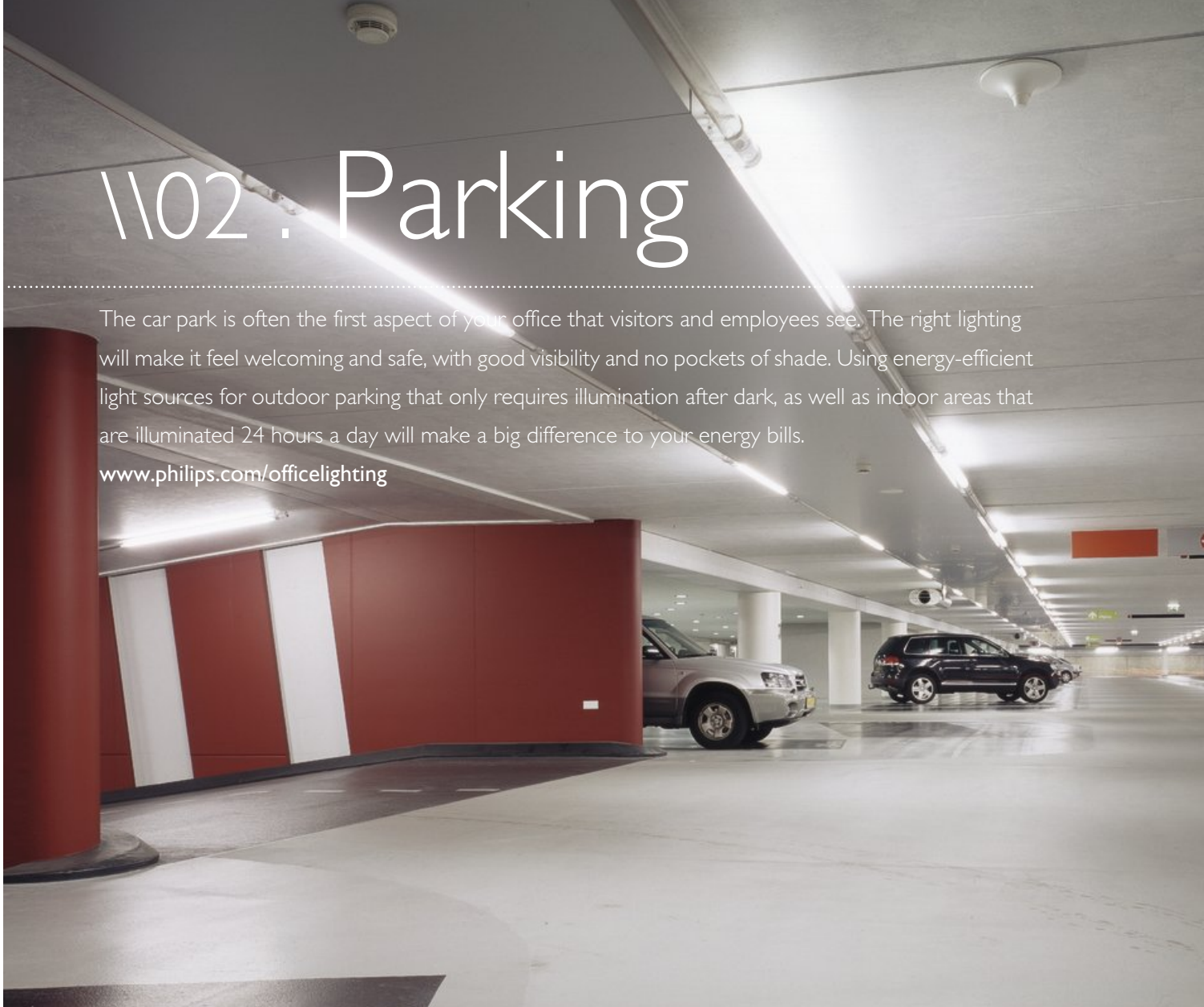
Bern Parkhaus, Maastricht, the Netherlands
