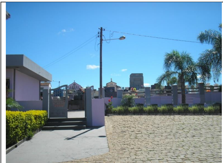
Fig.8: Cemitério Municipal de Piraí do Sul Fonte: Autor
