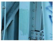
Échantillon avant prélèvement (pont ave. St-Pierre/ave. Dollard direction nord) pris depuis les plaques de renfort et une colonne
