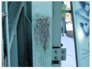
Échantillon après prélèvement (pont ave. St-Pierre/ave. Dollard direction nord) pris depuis les plaques de renfort et une poutre
