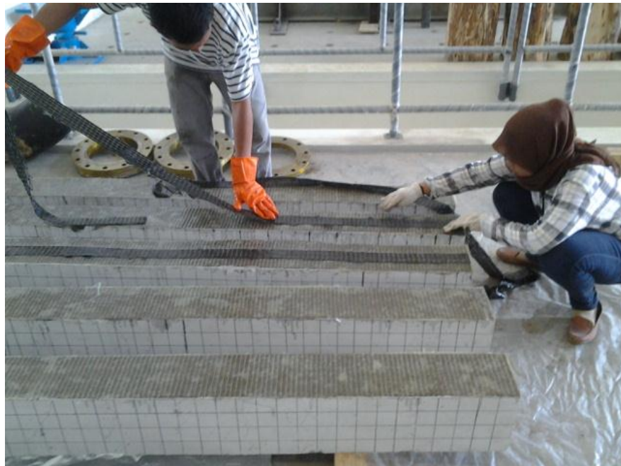
Pemasangan CFRP
