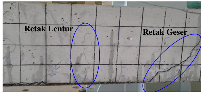
Gambar 4.20 Pola Retak Balok BGC-1
