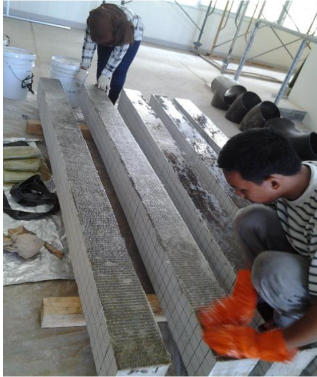
Pemasangan GFRP
