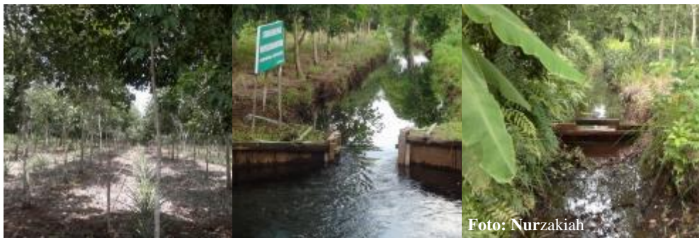
Gambar 13. Pengelolaan air sistem tabat di Desa Jabiren, Kalimantan Tengah
