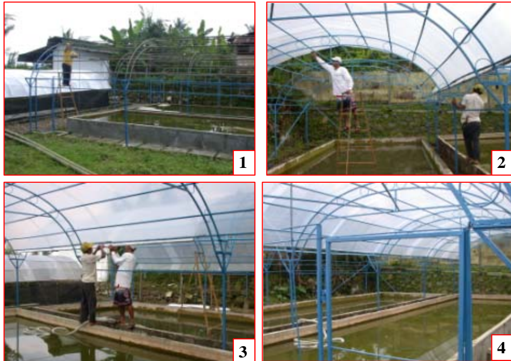
Gambar 2. Persiapan greenhouse dan kolam tanam. (1). Instalasi kerangka greenhouse , (2). Pemasangan UV Plastik, (3) Penguncian UV Plastik pada kerangka Greenhouse, (4) Greenhouse dan bak tanam yang siap dipakai.
