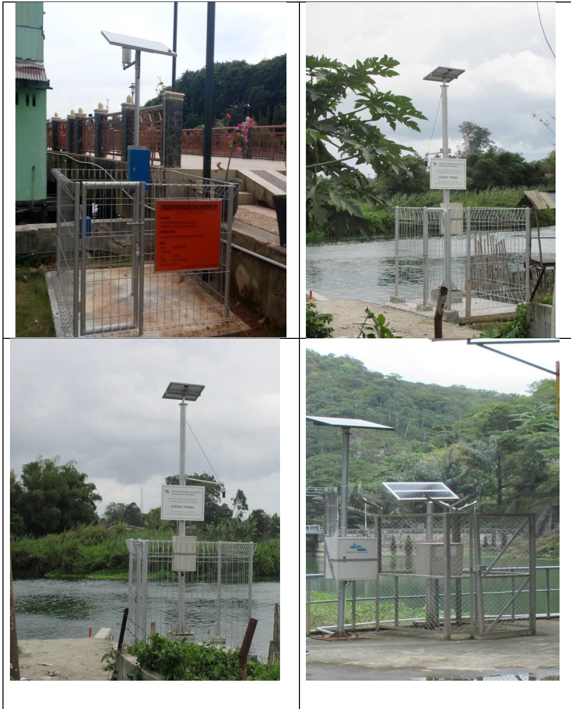
Gambar 6. Contoh Bangunan Pelindung Tidak Permanen
