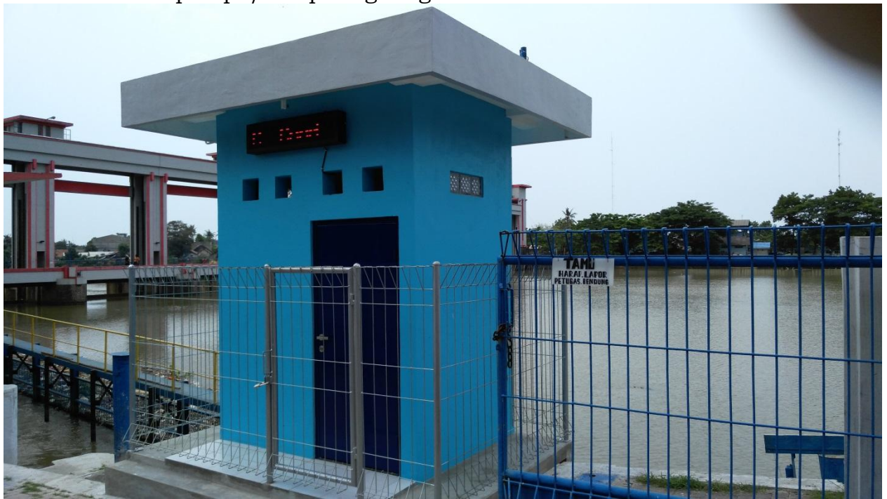
Gambar 4. Contoh Bangunan Pelindung Permanen
