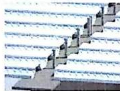
Pemasangan CBMDECK® pada balok baja
