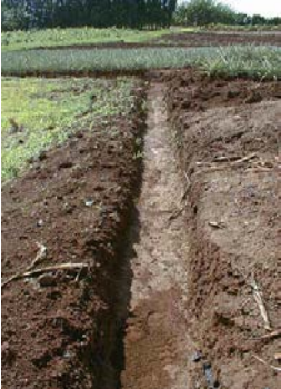
Drain de ceinture
