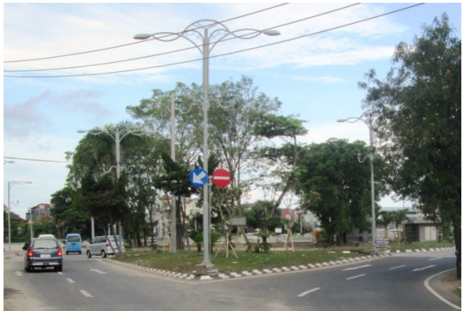
Gambar 4.15 Contoh Pulau Jalan dan Penempatan Rambu pada Pulau Jalan
