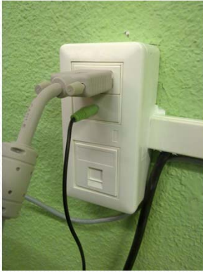
Toma pared conexión video proyector y altavoces PDI
