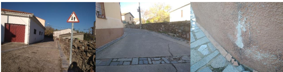
Figura 27: Estrechamiento, curva con poco radio de giro y marcas de rozamiento por el contacto de vehículos con la edificación en la Travesía de la Fuente que da acceso al núcleo de las Navas de Buitrago. Fuente: elaboración propia.
