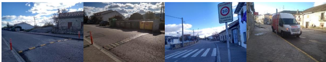
Figura 25: Medidas de calmado de tráfico en la Avenida Madrid. Bandas reductoras de velocidad, paso de peatones elevado con aviso de zona 30 en travesía peligrosa y vehículo parado en paso de peatones elevado.
