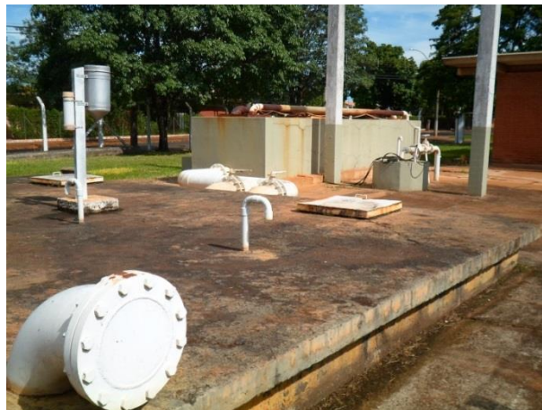
Foto 4.10 – Reservatório enterrado Presidente Vargas I
