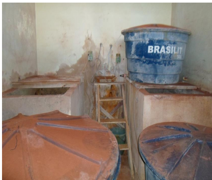
Foto 4.11 – Tratamento dos poços
