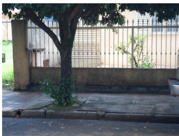
Foto 4.27 – Barramento na casa para conter alagamento
