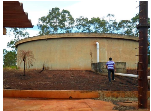
Foto 4.9 – Reservatório Distrito Industrial
