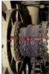
La flexibilidad y durabilidad excepcionales del Rapid Rubber Repair hace que éste Uretano sea apropiado para reparaciones de uniones de expansión.
