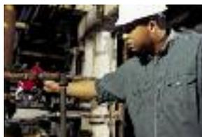
Estos accesorios roscados de la bomba de cenizas de fondo se sellan contra la vibración con los fijadores de tornillería de alto torque.
