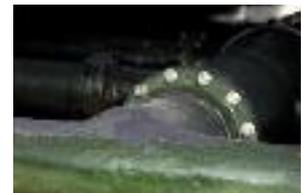
El Brushable Ceramic Epoxy, aplicado a tuberías superiores dentro de los depuradores, protege las tuberías de la abrasión causada por el goteo de las boquillas de SO<sub>2</sub>.
