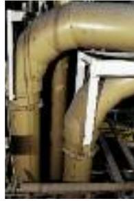
El Pneu-Wear aplicado a codos de alimentación protege el equipo contra pequeñas partículas de abrasión.
