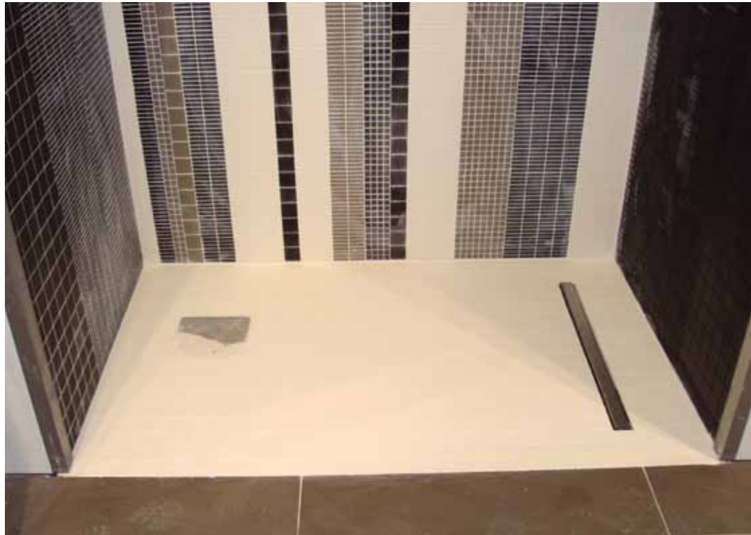
Detalle plato con desagüe en forma de canal
