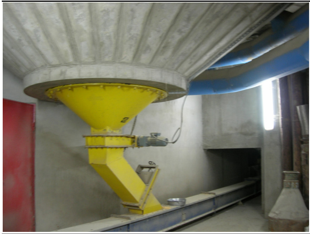
Box 1.17 TMO Grain Siloh
