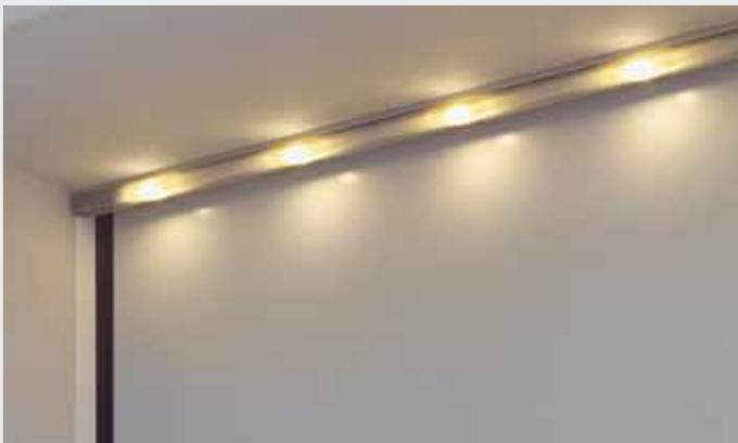
Barre d'éclairage à LED montée sur le linteau
