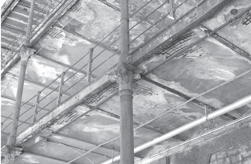
Particolare di una colonnina in ghisa in Porto Vecchio che sostiene le voltine in calcestruzzo armato realizzate con il sistema Monier.
