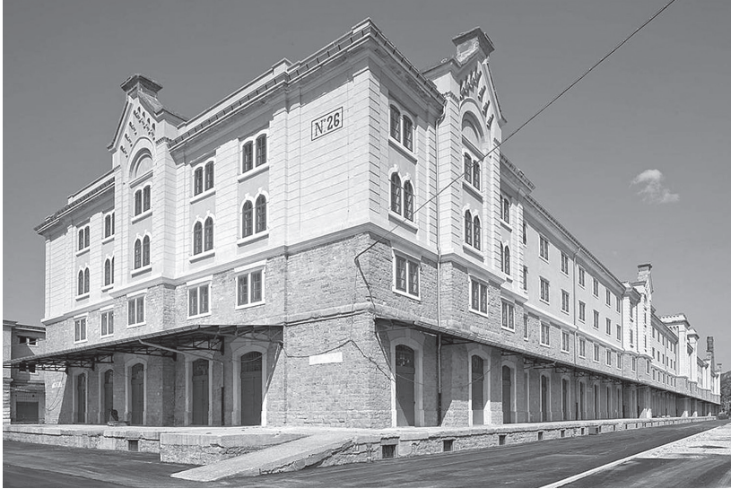
Il magazzino 26 dopo l'intervento di restauro effettuato completato nel 2009.
