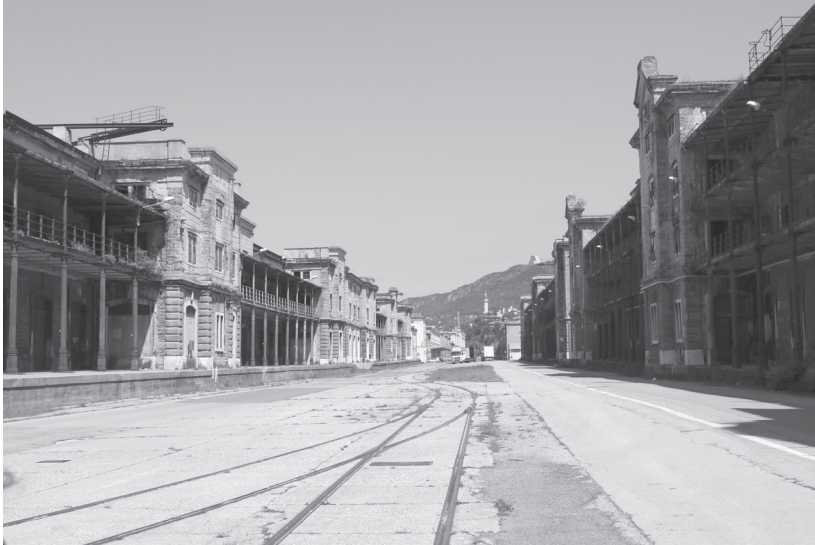
Strada di Porto vecchio dove i prospetti dei magazzini conservano i ballatoi in ferro e ghisa.
