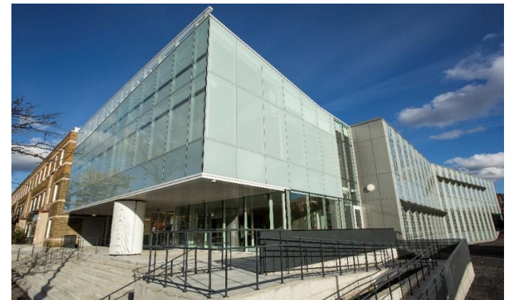
Vue extérieure de la bibliothèque Marc-Favreau
