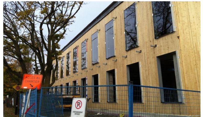
Photos de chantier de la bibliothèque Benny
