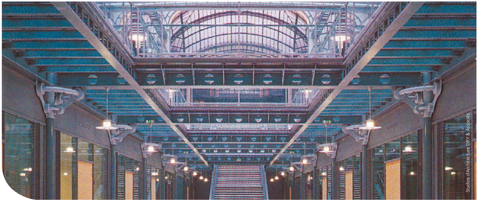
Figure 4: Rénovation à l'aide de poutrelles ACB® au siège du Crédit Lyonnais à Paris
