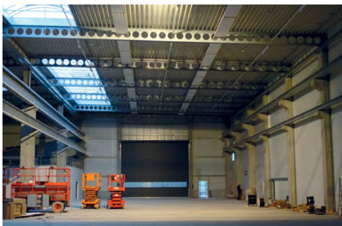
Figure 2: Poutre de toiture ACB®
