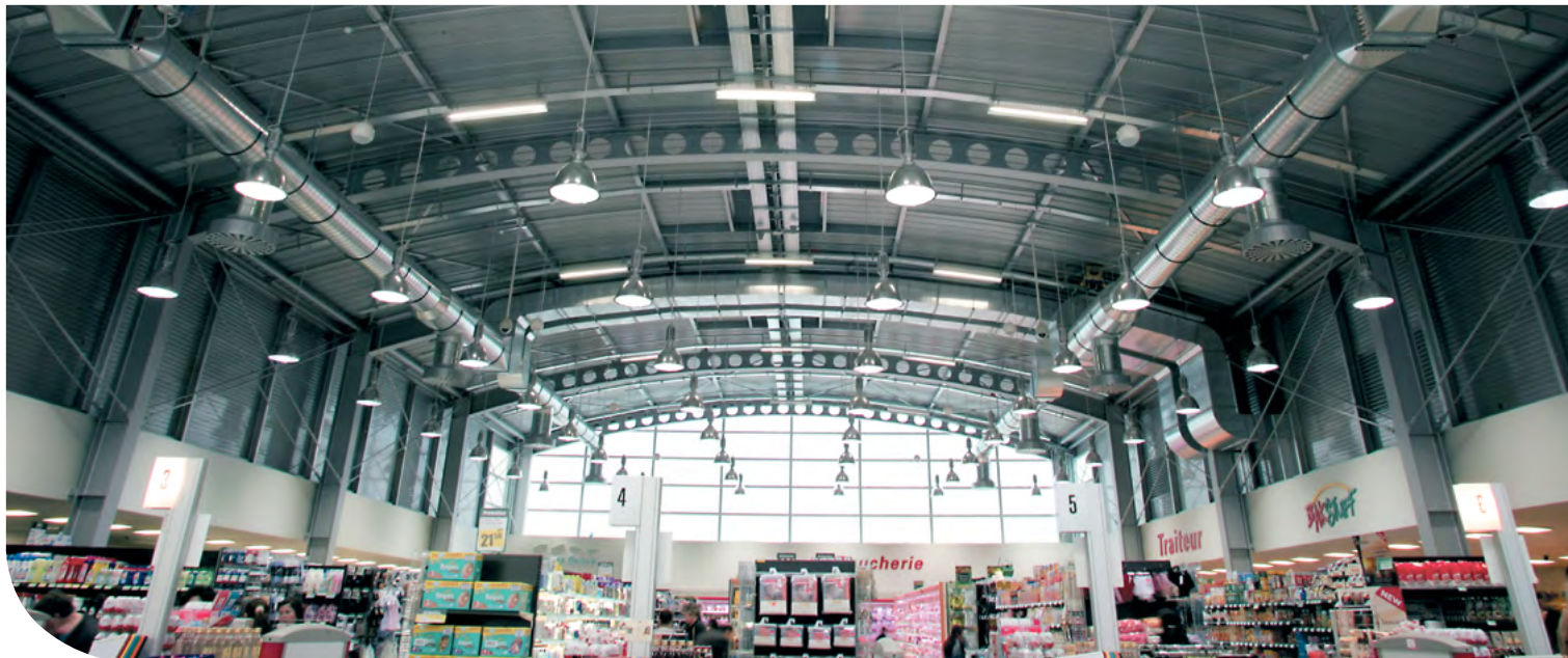
Poutres cellulaires contrefléchées de 25 mètres
