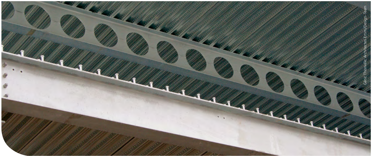
Figure 26: Exemple poutre mixte de plancher
