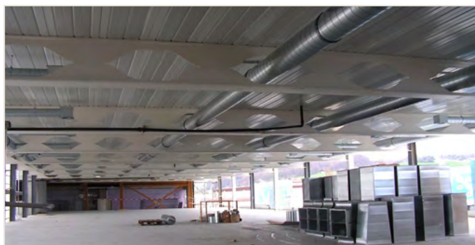
Figure 24a: Poutres alvéolaires Angelina® de plancher
