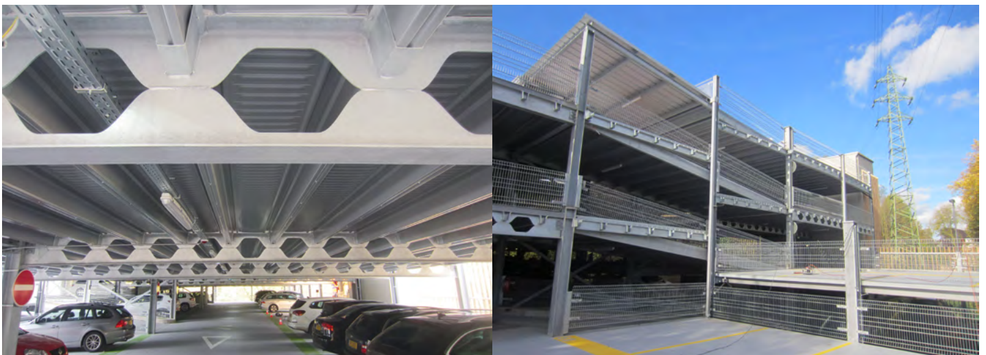
Figure 5: Poutre alvéolaire dans la construction de parking
