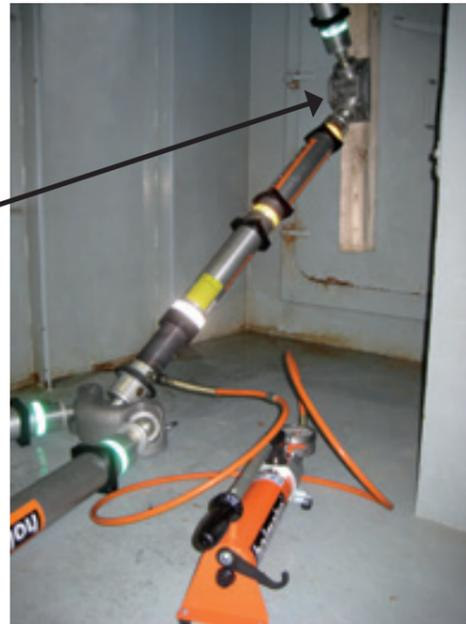
Apuntalamiento en varias direcciones con un soporte de 3 cabezales giratorios y un soporte en 2 direcciones.
