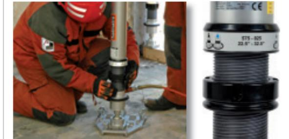
El sistema se asegura manualmente por medio de contratuercas. Como para ser bloqueada no necesita fuerzas adicionales, ésta es una buena elección para utilizar, p.e., en un apuntalamiento de derrumbe de edificios donde no deben ser perturbadas las fuerzas de equilibrio para evitar derrumbes secundarios. Todos los puntales pueden ser equipados con este sistema de bloqueo.
