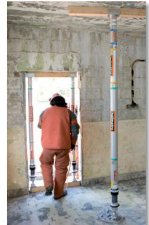
Puntales combinados con madera, protegiendo las rutas de acceso y salida de un edificio colapsado.
