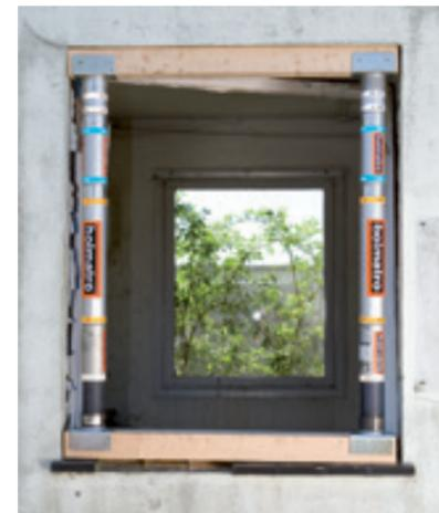
Puntales manuales con extensiones, cabezales soporte de viga y madera, estabilizando una ventana.
