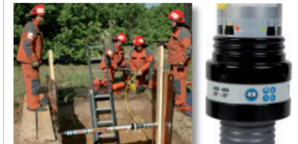
El sistema se asegura automáticamente, lo que permite un apuntalamiento remoto: el proceso por el que un puntal se coloca en una zona insegura y se extiende desde una situación alejada por medio de presión neumática o hidráulica. Sólo los puntales neumáticos o hidráulicos pueden ser equipados con bloqueo automático.
