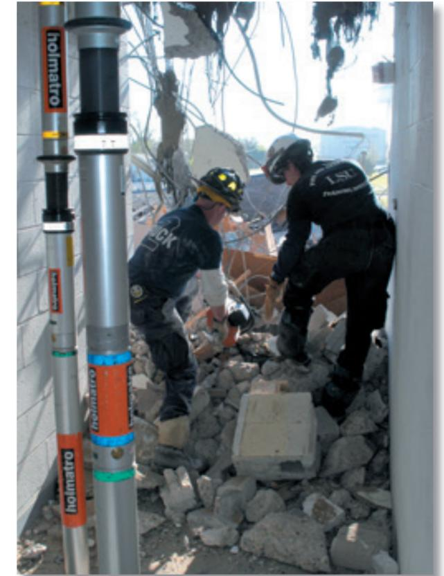
Estabilización de edificio colapsado con puntal manual con contratuerca.
