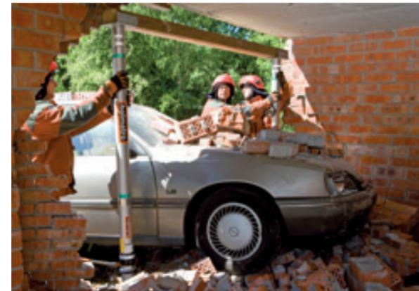
Colocación de dos puntales con cabezales soporte de viga y una viga, estabilizando un edificio. Los puntales hidráulicos con contratuerca pueden extenderse cuidadosamente por medio de la bomba manual.
