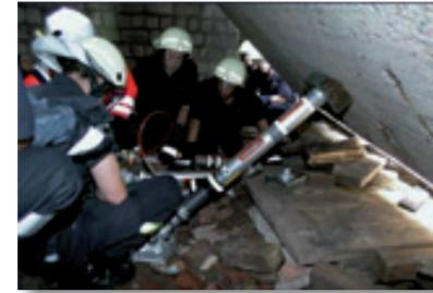
Estabilización y elevación, con puntal hidráulico con contratuerca, de una estructura colapsada
