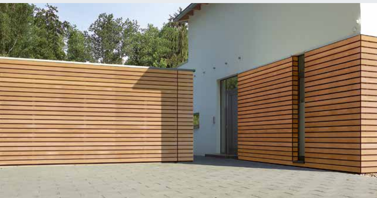
Opláštění dřevěnými panely v místě stavby
