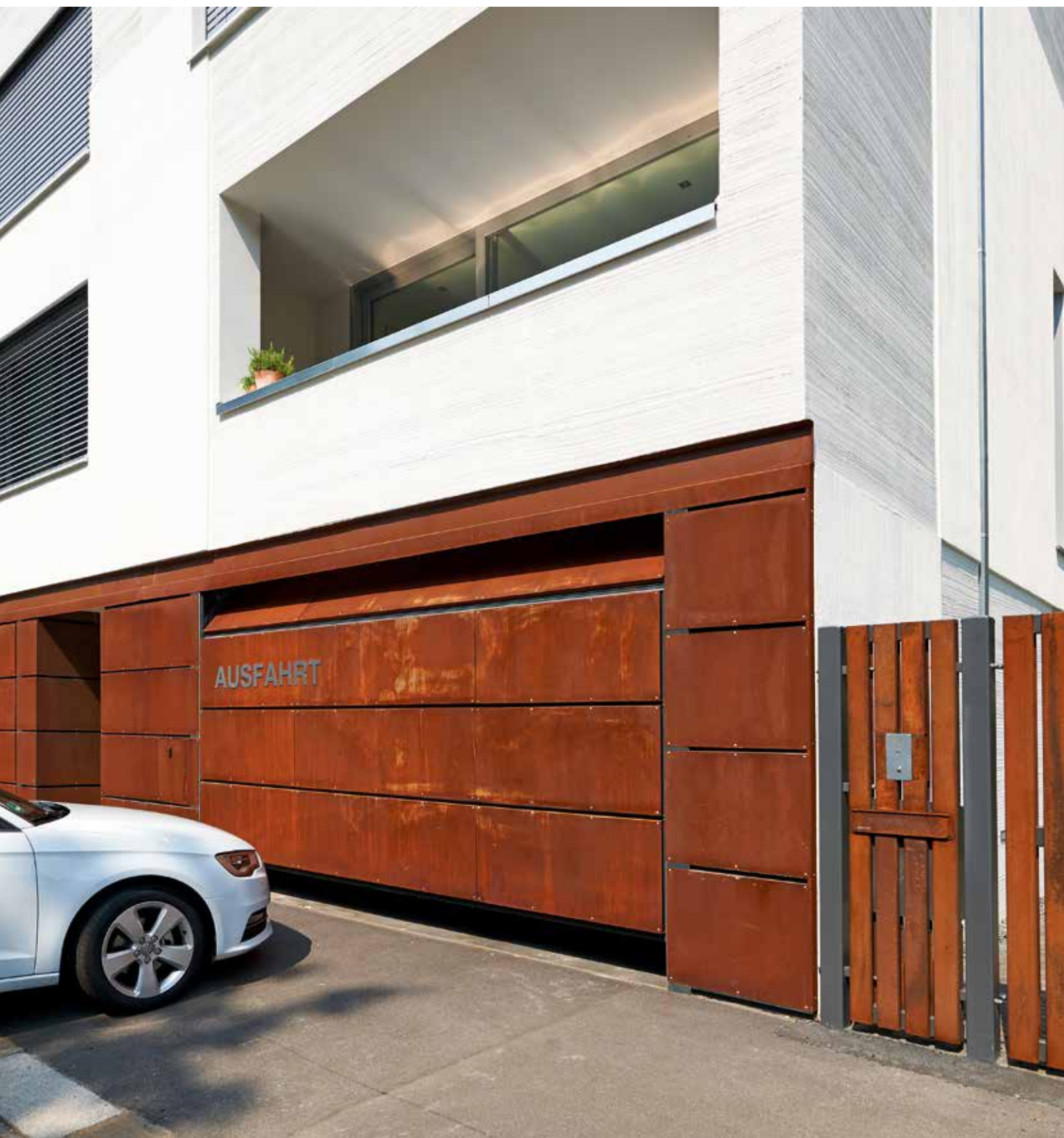
Opláštění vrstvenými lisovanými deskami v místě stavby
