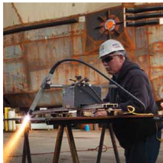
Řezání a drážkování dráhy
