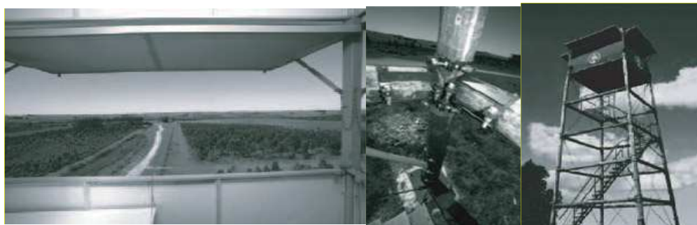
Foto N° 6, 7 y 8. Torres de Vigilancia forestales. Gentileza de Alerta Forestal S.A. 2008.
