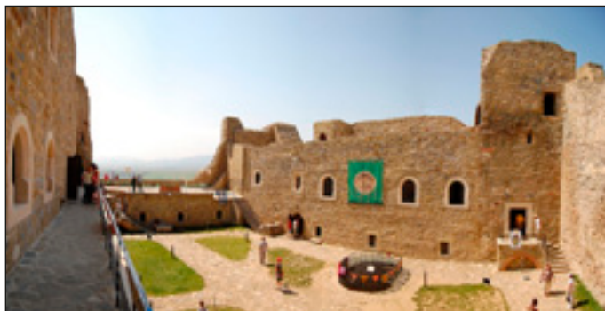
Fig. 42. Panoramă realizată din cinci cadre verticale la Cetatea Neamțului.
