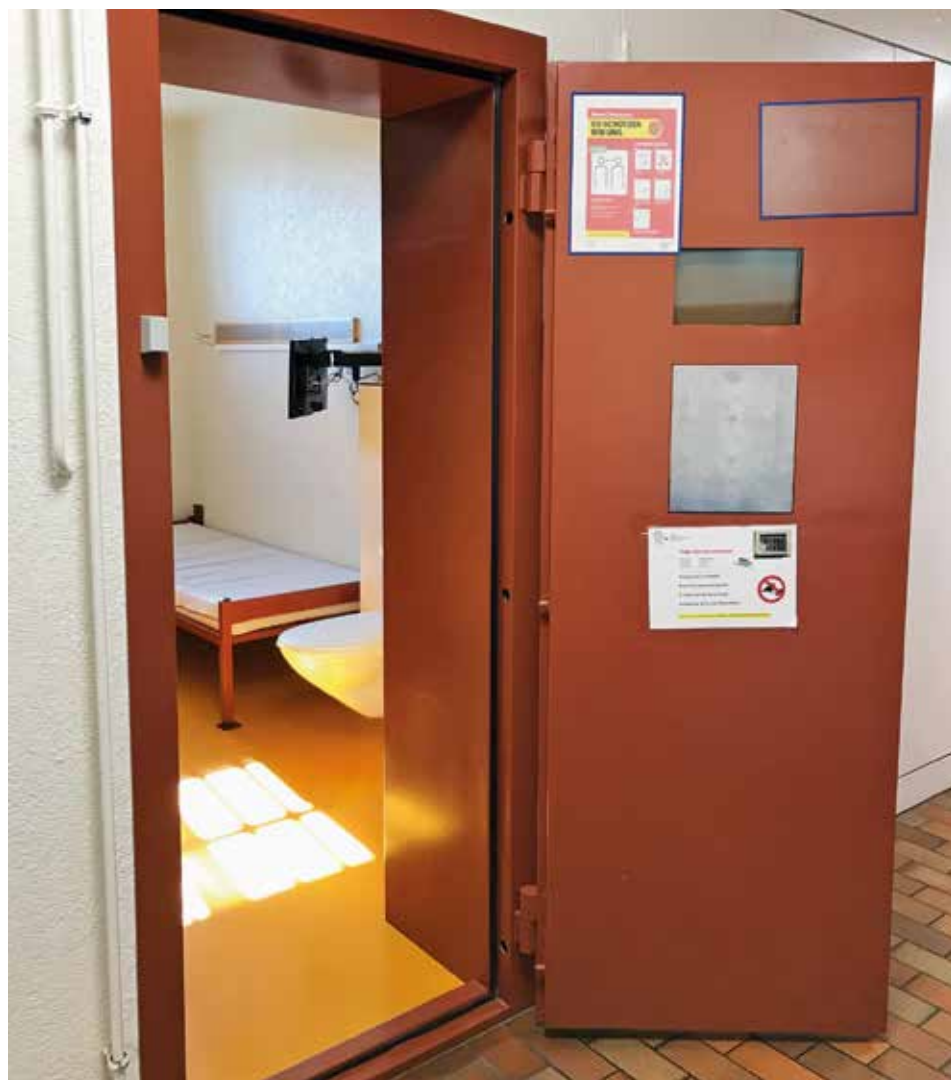
En raison de la pandémie de coronavirus, la prison de Horgen, qui était fermée depuis fin 2019, a été rouverte début avril pour y installer les nouveaux arrivants placés en quarantaine et les détenus placés en isolement (photo : cellule de l'unité d'isolement). Photo : EJ
