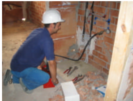
Figura -9- Llenado de la instalación
