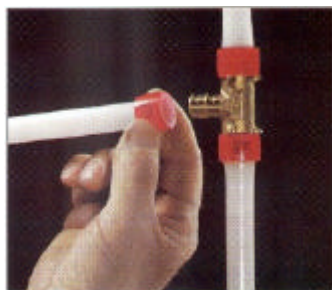
Figura-5-Montaje anillo
