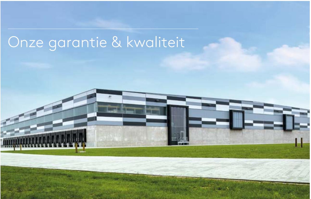
AWP gevelpanelen voor het distributiecentrum van Lidl Heerenveen, Nederland
