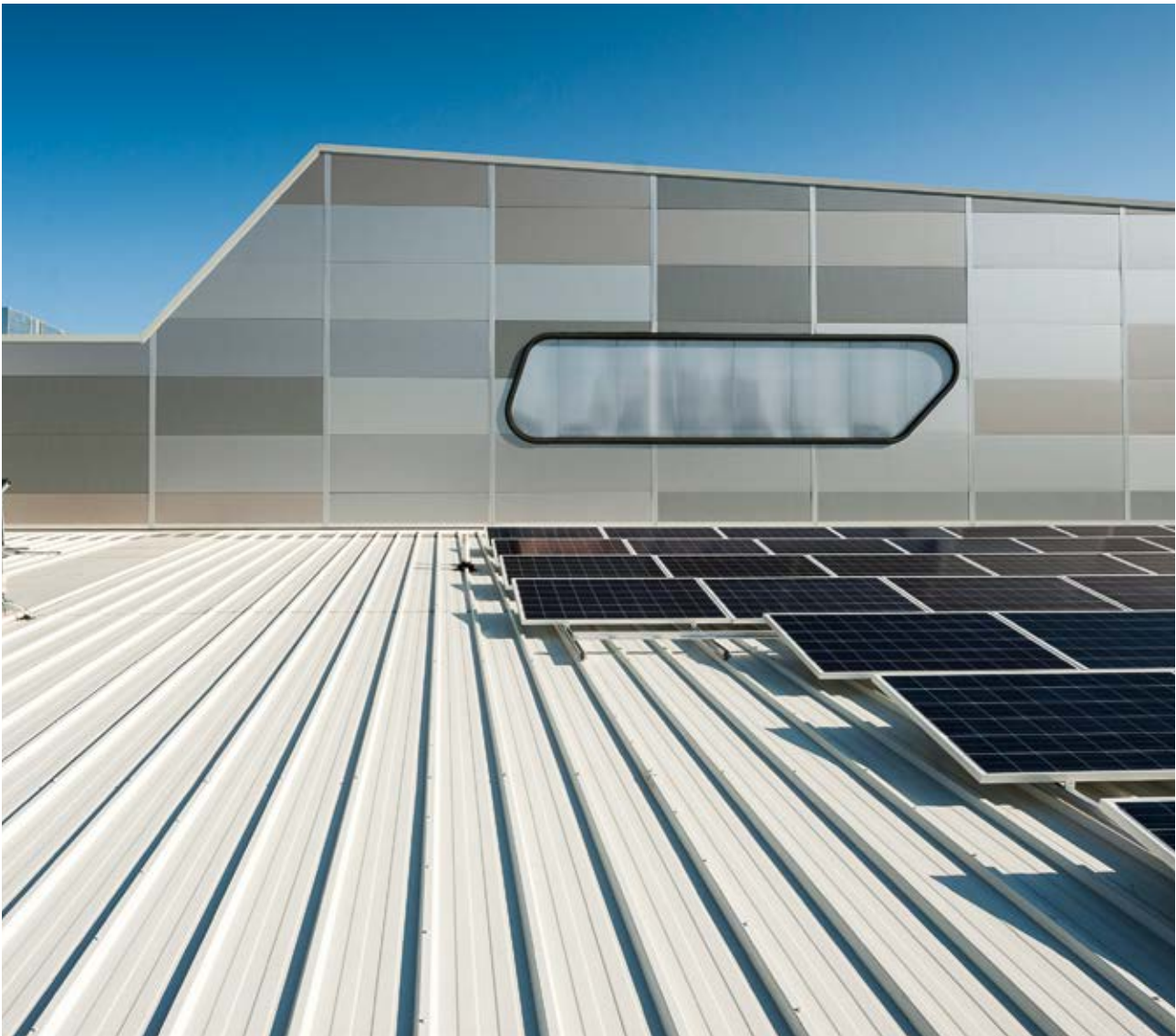
RW Trapezoidal Roof dakpanelen gecombineerd met zonnepanelen
