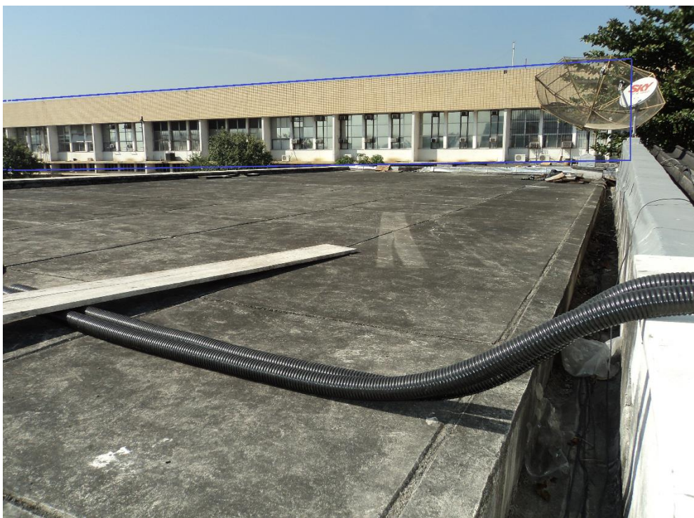
Figura 41: Foto tirada no local do projeto no dia 25/07/2013, mostrando o Bloco H como potencial fator de sombreamento do SF para direção ODF.
