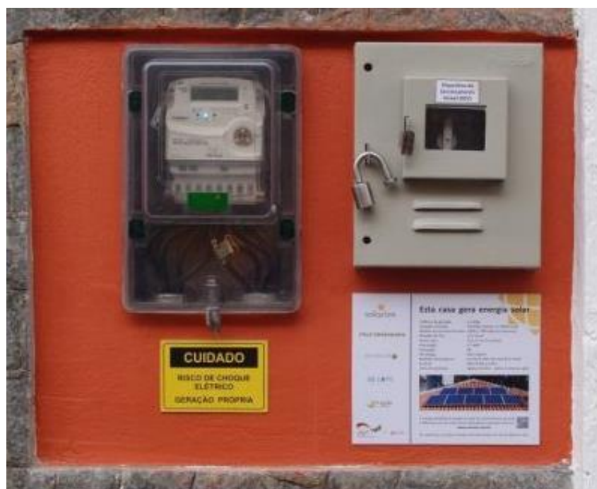
Figura 48: Imagem do Medidor e do DSV do Primeiro Sistema de Microgeração Fotovoltaico no Sistema da Light SESA [39].
