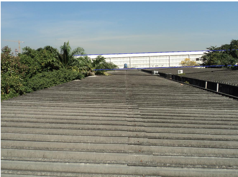
Figura 39: Foto tirada no local do projeto no dia 25/07/2013, do prédio do Bloco I como potencial fator de sombreamento para módulos com direção Norte.
