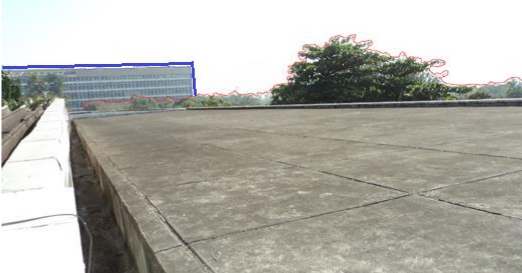
Figura 40: Foto tirada no local do projeto no dia 25/07/2013, mostrando potenciais fatores de sombreamento em azul (prédio do Bloco A) e vermelho (vegetação) para direção ODF.
