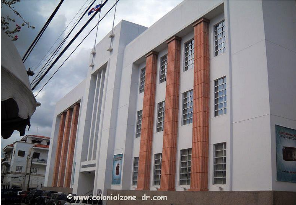
PALACIO DE LAS TELECOMUNICACIONES.
