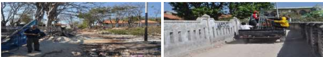
Gambar 3. Kondisi Jalan di Pulau Mandangin
