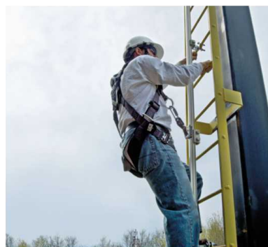
Entretien sur des pylônes
