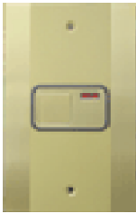
Ejemplo del pulsador exterior de llamada al ascensor
